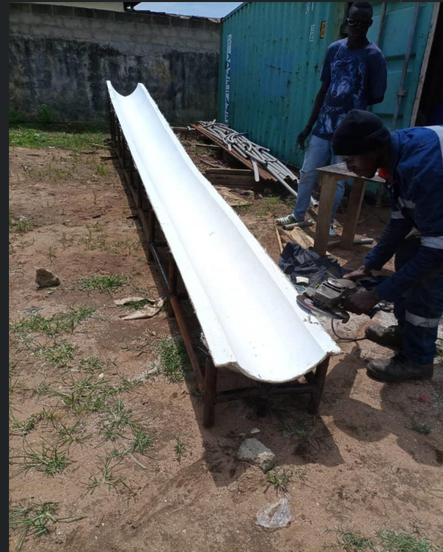
Photo 21 démoulage moule extérieur
