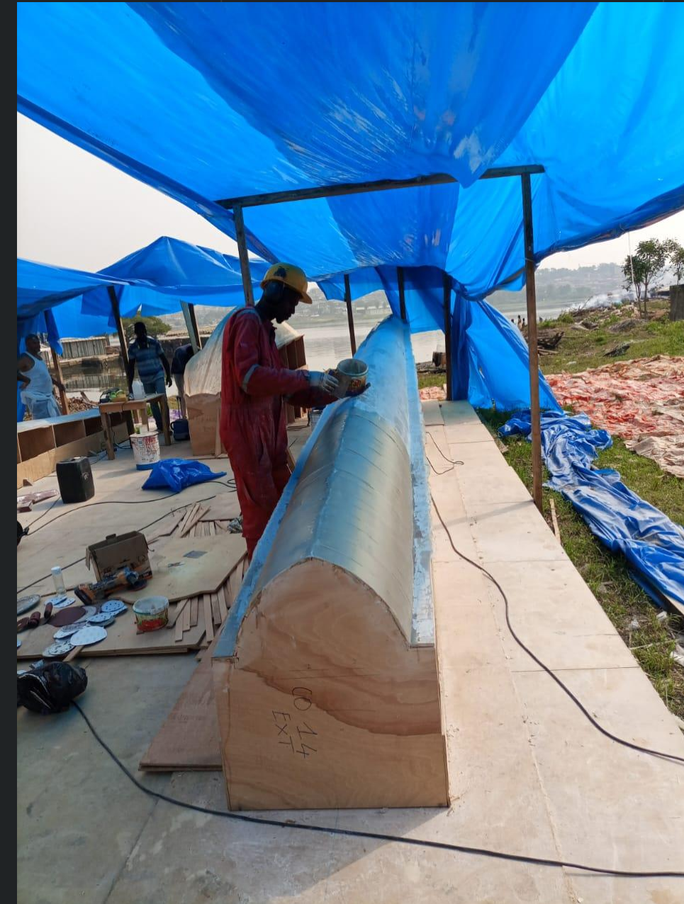
Photo 19 masticage ponçage moule extérieur
