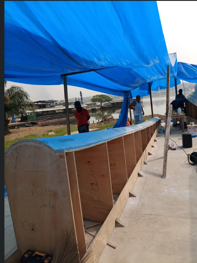
Photo 18 masticage ponçage moule intérieur
